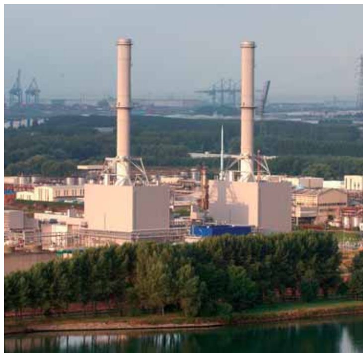
France : l'unité de cogénération de la raffinerie de Gonfreville
