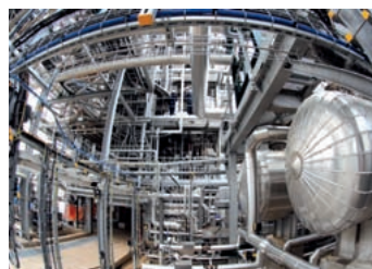
L'unité de démonstration MTO ( Methanol to Olefins ) du site pétrochimique de Feluy, en Belgique. Cette technologie contribue à diversifier les sources d'approvisionnement de la pétrochimie.
